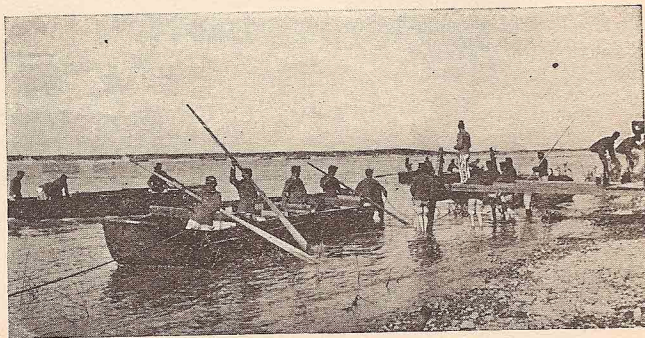
Eben wird eine schwimmende Unterlage durch Pioniere in die Brückenlinie eingeführt.
